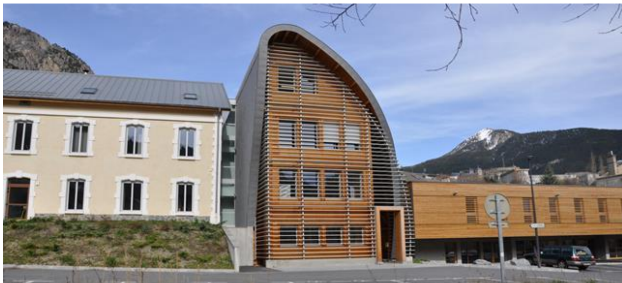
Les locaux d'Altipolis à Briançon : l'arche formant le A d'Altipolis, accolée à un bâtiment rénové de la caserne Berwick et à droite, l'hôtel d'entreprises. Crédit : Altipolis.
